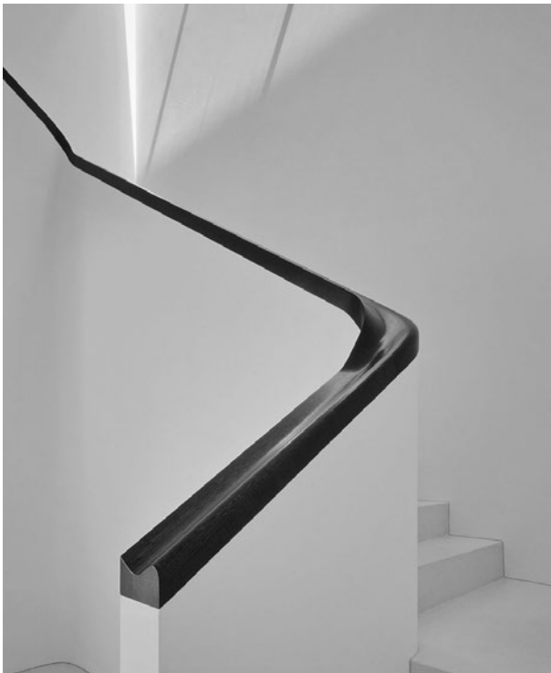
Ein wichtiger Vorteil von Bugholz ist, dass die Maserung des Holzes immer mit der Form mitläuft. (Bild: K. Winkler AG)
